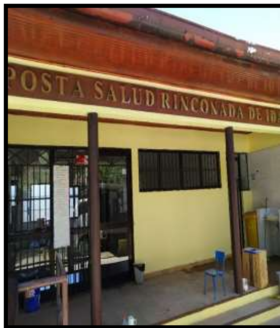
REPOSICION DE PUERTA DE ACCESO
